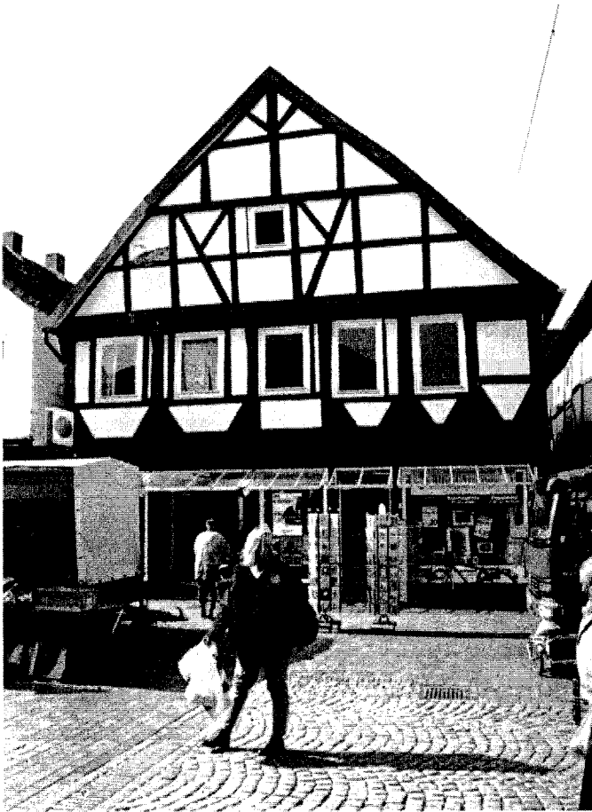
Abb. OF - 1: Blick auf den Ostgiebel (Achse G-A) mit vollständig modern erneuerter EG-Ladenzone, weitgehend erhaltenem Kernbaugesüße im OG und komplett erneuertem Gefüße im Giebeldreieck.
