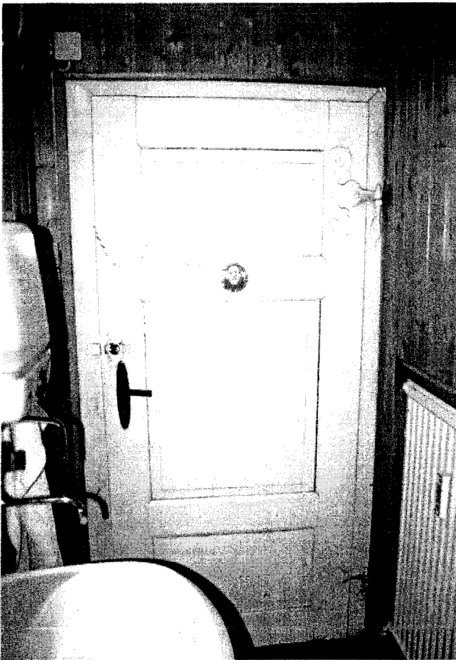
Abb. 1.3 - 1: Dreifeldrige Rahmenfüllungstür mit abgeplatteten Füllungen und eingestemmttem Schloß, unten gekürzt.
