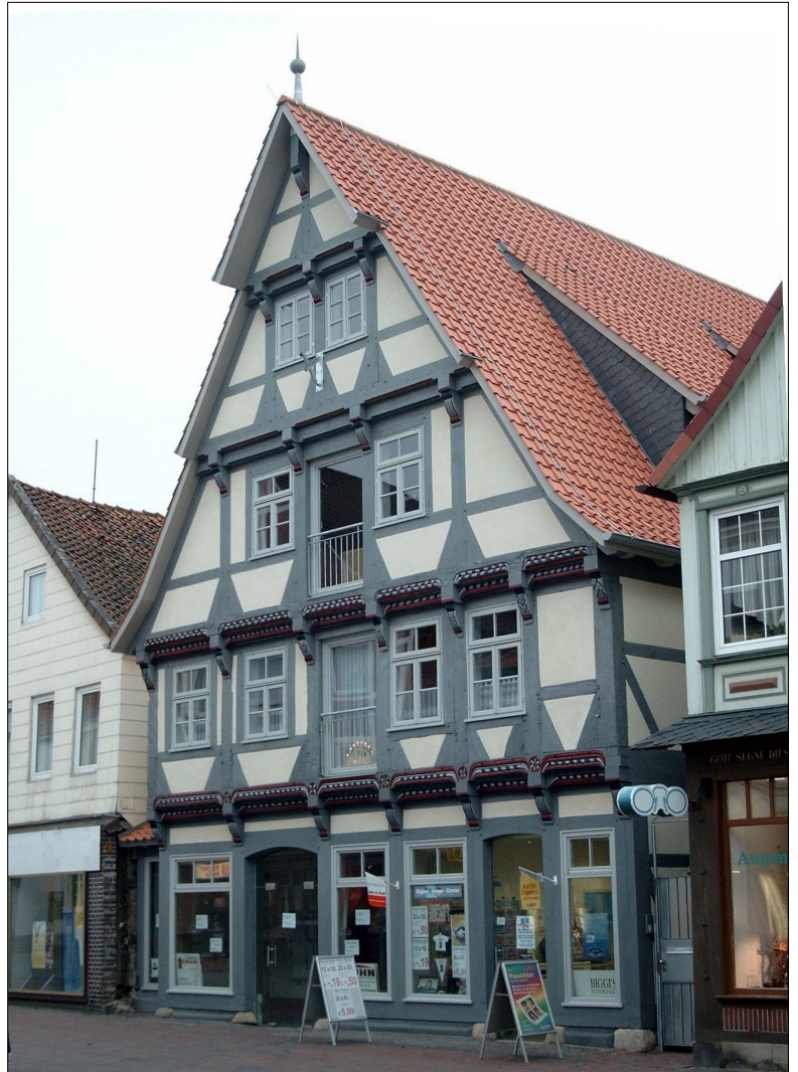
Abb. 17: 4-fach vorkragender Ostgiebel nach Fertigstellung 2003 – dreiflügelige, nach außen zu öffnende Holzfenster, - rekonstruierte Ladeluken und Giebelpfahl – Eindeckung mit Linkskrempern.
