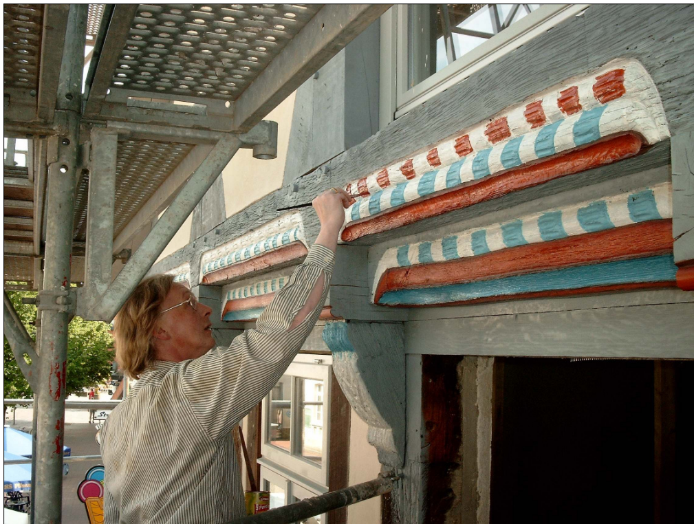
Abb. 14: Farbige Fassung der Zierformen an Schwellen, Füllhölzern, Deckenbalkenköpfen und Knaggen mit Leinölfarben.
