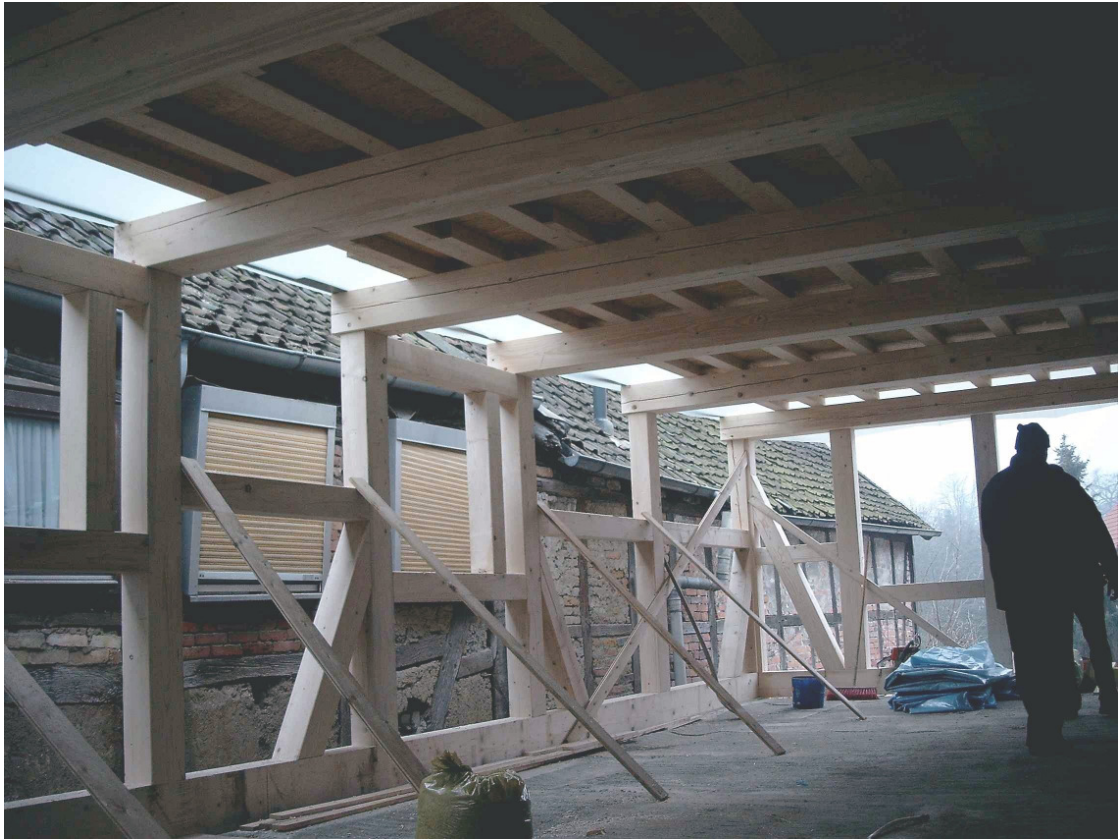
Abb. 9: Obergeschoß - rekonstruiertes Fachwerk in Konstruktionsvollholz.
