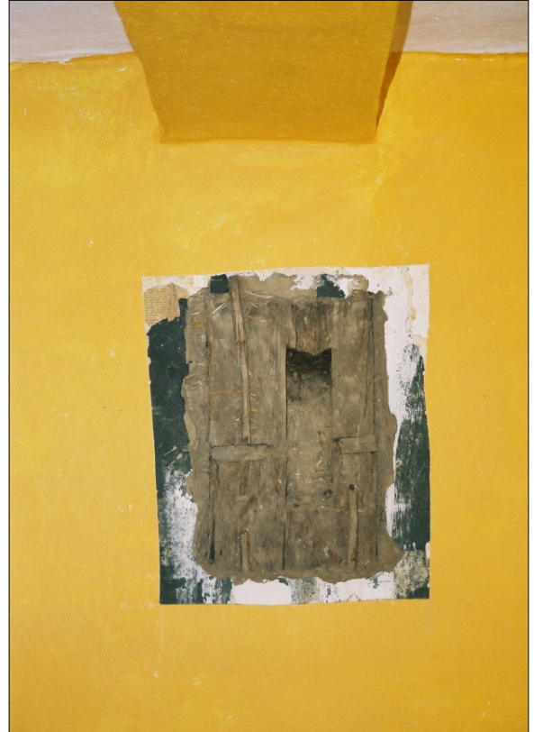
Abb. 4: Befunddokumentation einer Suchstelle: abgebeiteter bauzeitlicher Eichenfassadenständer mit verfülltem Zapfen- und Holznagelloch einer entfernten Kopfstrebe zum Deckenbalken.
