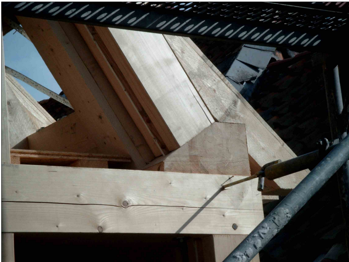
Abb. 10: Historische Aufrähmzimmerung des rekonstruierten Dachstuhls mit aufgekämmten Aufschieblingen.
