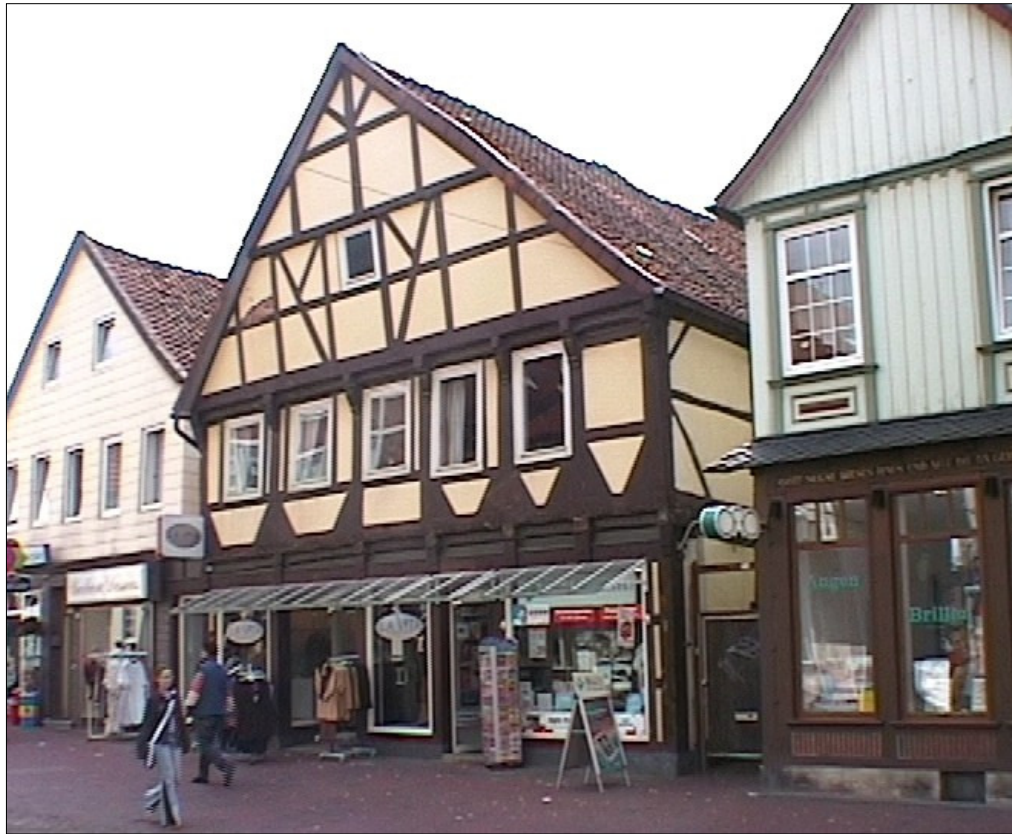
Abb. 1: Steinweg 22 - Ostgiebel zur Fußgängerzone - Zustand 2002 - Ackerbürgerhaus der Renaissance mit barockem Giebeldreieck und stark überformtem Erdgeschoß.
