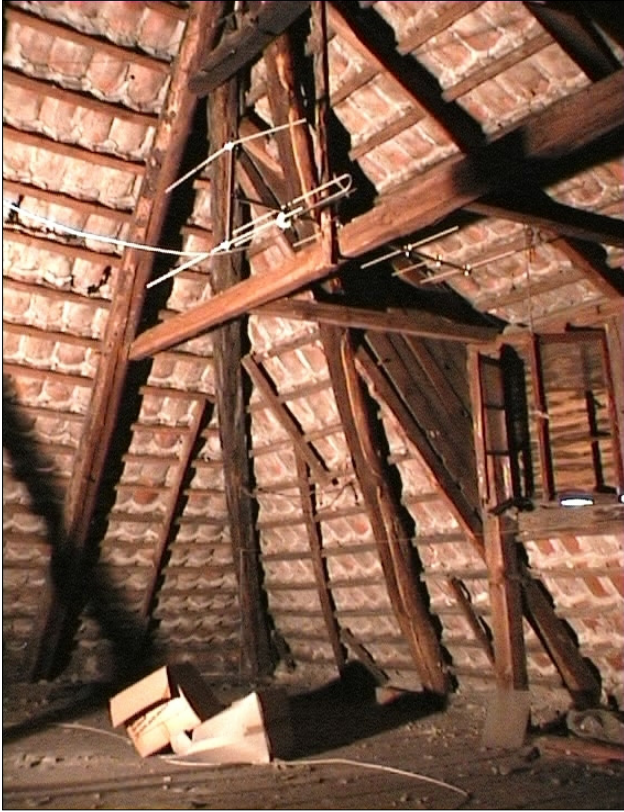
Abb. 3: Blick nach Südwesten mit Abwalmung und Schleppegaupe an der westlichen Dachseite.
