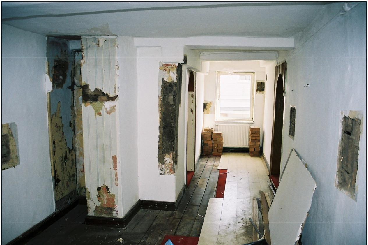
Abb. 5: Obergeschoß - Blick nach Osten - abgesägter Unterzug mit bauzeitlichem, ehemals freistehendem Ständer in Bildmitte .
