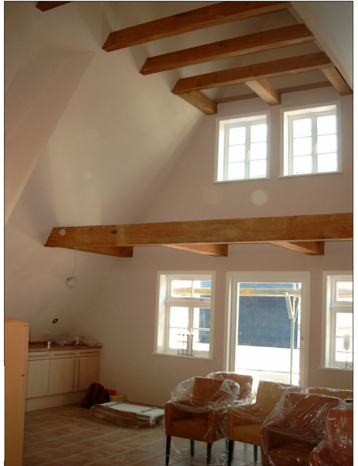
Abb. 15: Dachgeschoßwohnung - Blick nach Nordosten – Stichgebälk in Kehrliegel- und Hahnenbalkenebene.
