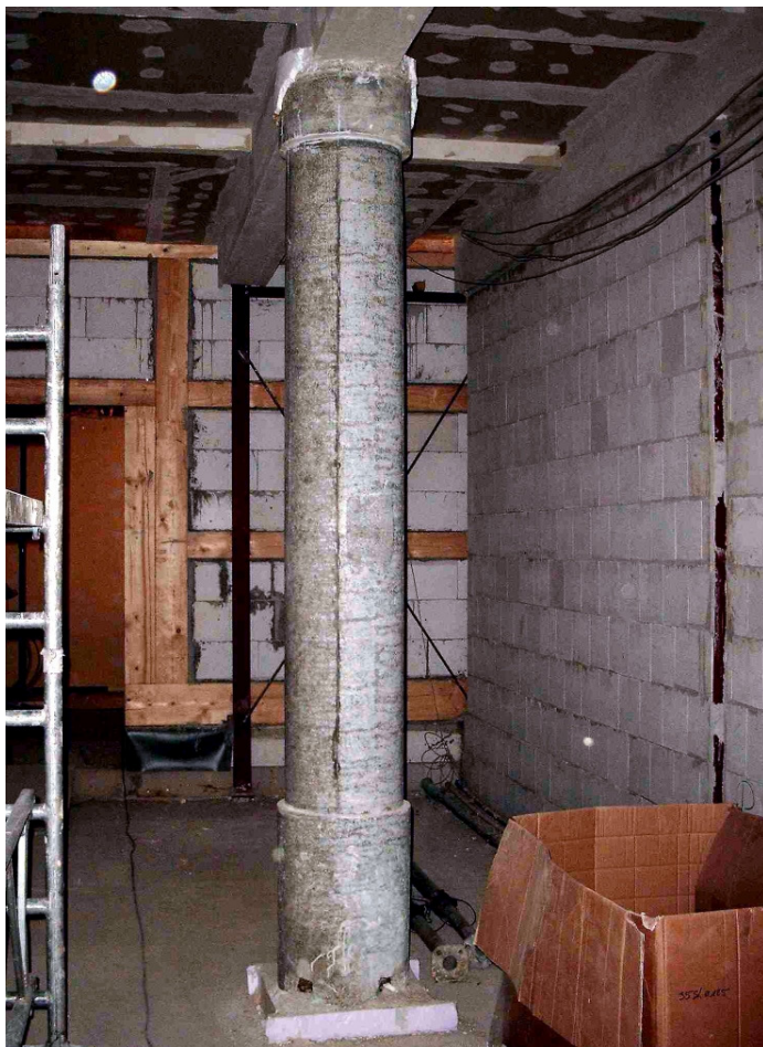
Abb. 12: Erdgeschoß - südlicher Laden - aussteifende Säule mit Basis und Kapitell - im Hintergrund westliche Fachwerk-Giebelwand.
