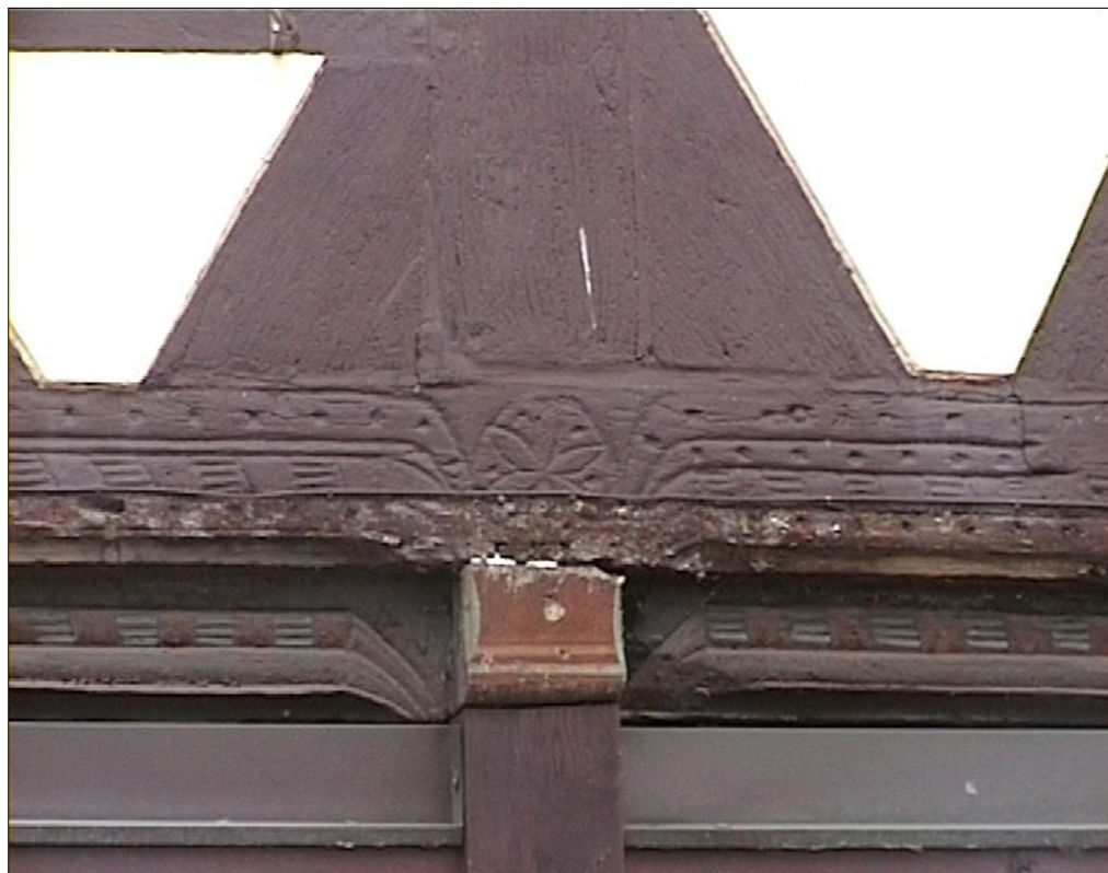
Abb. 2: Detail der Geschoßvorkragung über dem Erdgeschoß – Füllhölzer und OG-Schwelle mit Schiffskehlmotiven und Rosettenzier über dem Balkenkopf.
