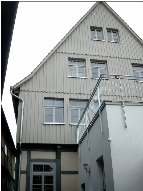
Abb. 18: Westgiebel mit senkrechter Verbretterung mit Deckleiste – moderner Anbau mit Dachterrasse.
