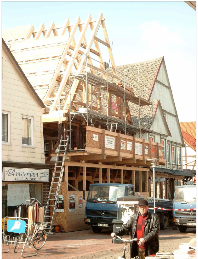
Abb. 13: Richten des rekonstruierten Giebel-dreieckes aus Eichenfachwerk vor aufgestellten Gespärren - fußgängerzonentaugliches Baugerüst
